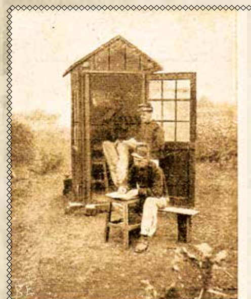
LA CABINE TÉLÉPHONIQUE. — Elle supprime l'inconvénient des lourdes voitures du train; on peut ainsi multiplier les postes. A l'intérieur, un appareil est installé; il n'y a plus qu'à réunir les fils.
